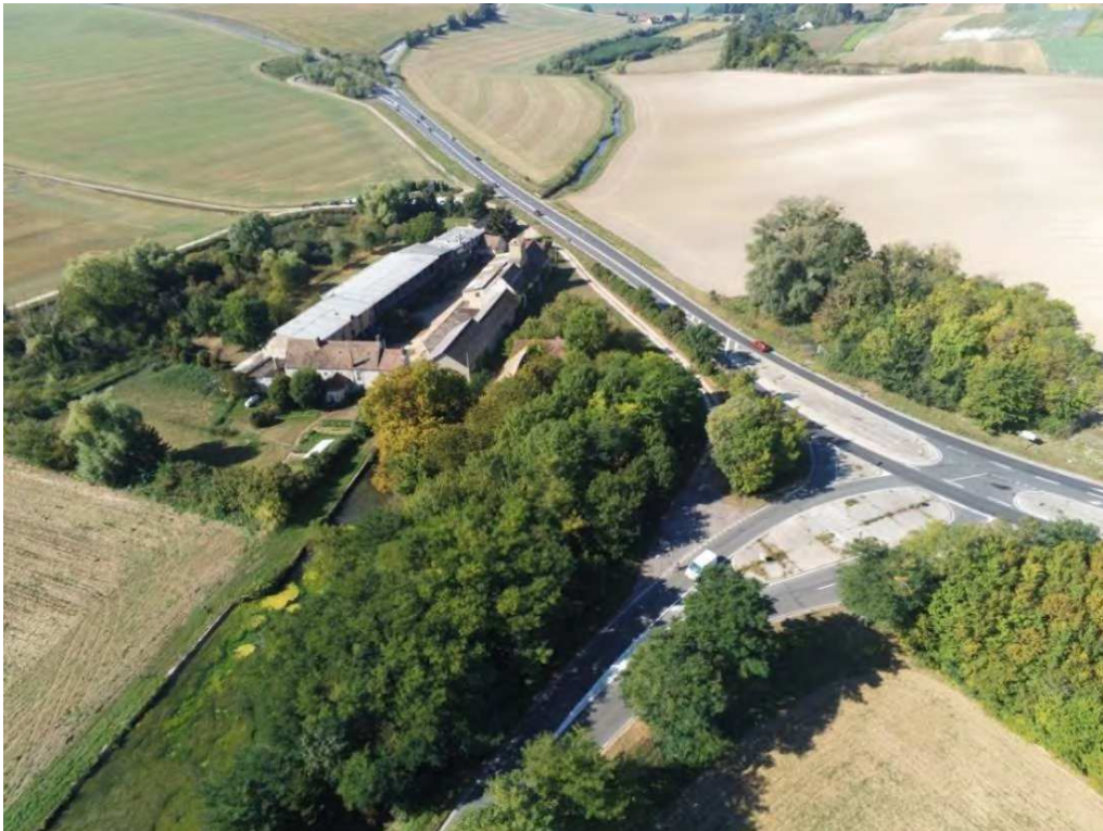
Vue satellite du site de la Ferme Mort-Moulin à Chavenay
