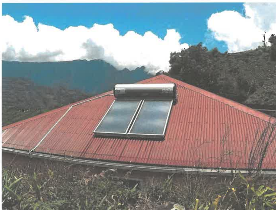
Installation de chauffe-eau solaire à Ilet-à-Cordes (Cilaos) dans le cadre de l'opération Village Solaire de la CIVIS
