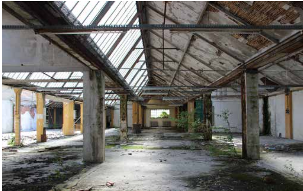
Site Loisin, Montceau-les-Mines © Ville de Montceau-les-Mines
