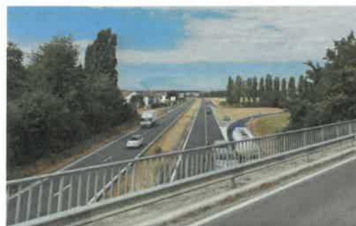
Vue sur la RN4 depuis Rozay-en-Brie
