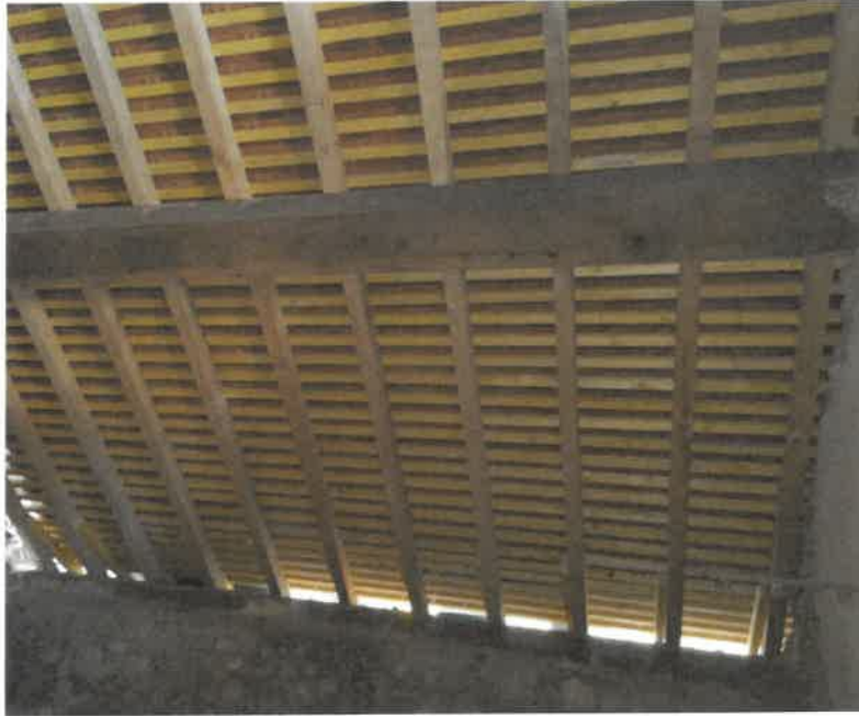
Chantier phase 1 (juin 2021)
