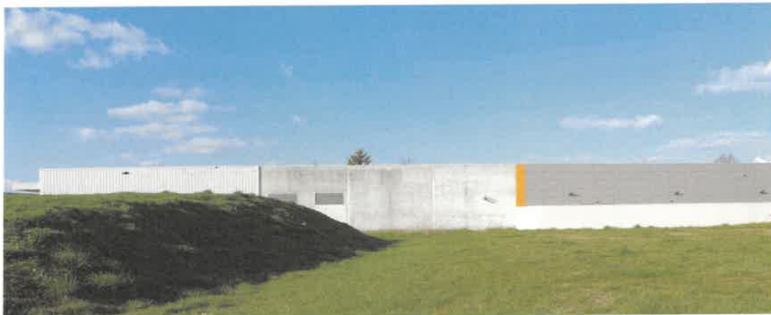
Existant – dos du bâtiment (sud-est)
