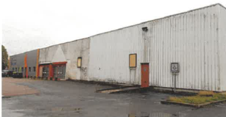
VUE 1 - ETAT EXISTANT
