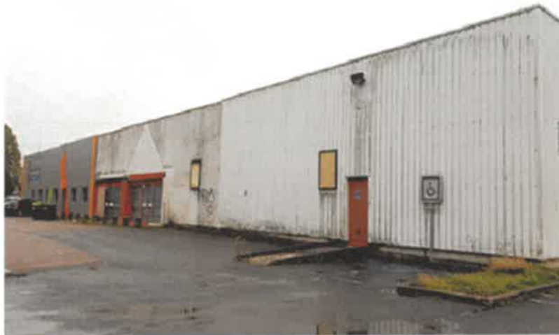
VUE 1 - ETAT EXISTANT
