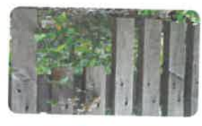
Des barrières avec des trous pour les hérissons
