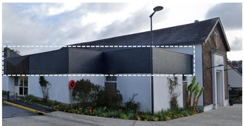
[Remplacement des ardoises verticales par bardage zinc]
