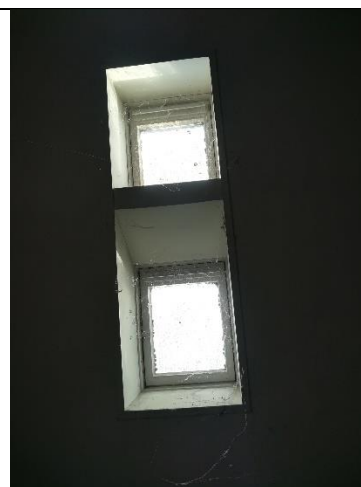
Menuiserie simple vitrage sur châssis aluminium
