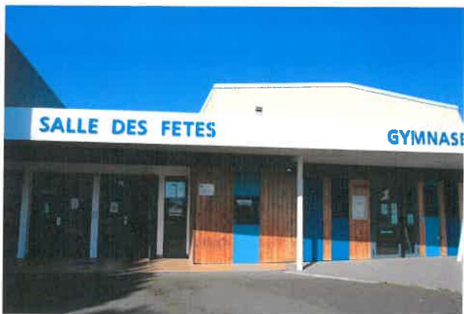
Prise de vue façade extérieure de la Salle polyvalente et du gymnase
