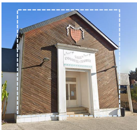
[Remplacement du bois par bardage zinc]
