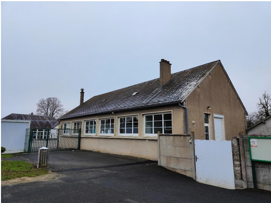
Façades Nord et Ouest
