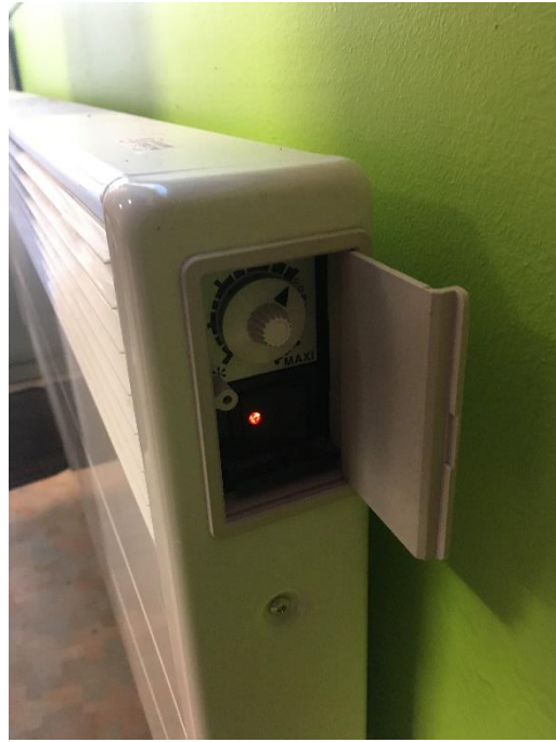
Photographies 3 et 4 : Salle polyvalente. Convecteur électrique ancien. Consigne de température par thermostat individuel non programmable. Entrée d'air dans coffre de volet roulant.
