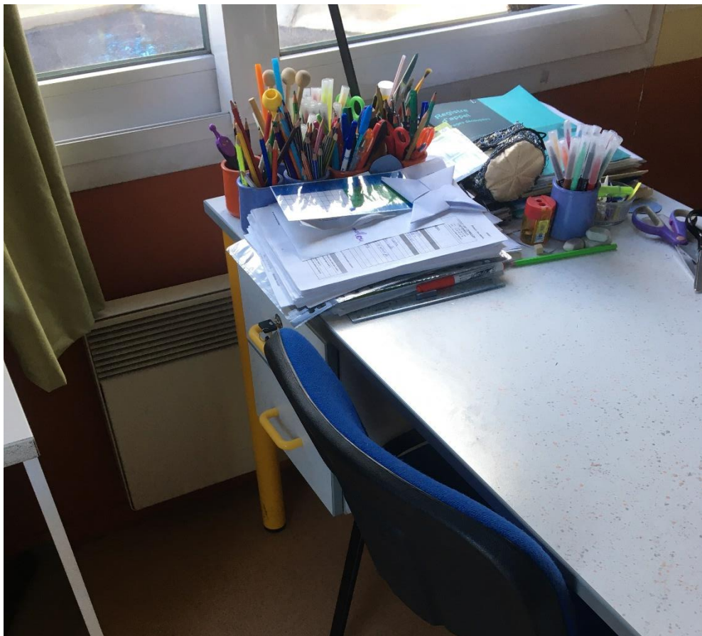
Photographie 8 : Salle de classe 2. Double vitrage coulissant. Convecteur électrique ancien avec obstacle devant.
