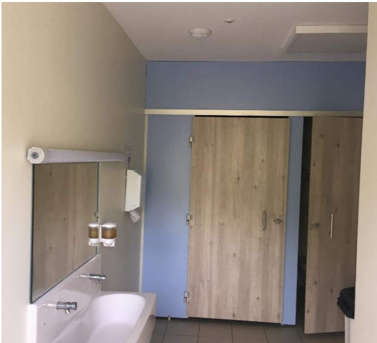
Photographie 11 : Extraction hygroréglable. Pavé LED avec détecteur. Robinet temporisé.
