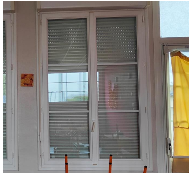
Menuiseries présentes sur le bâtiment
