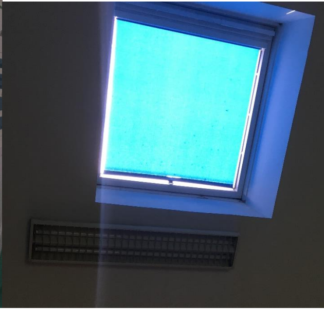
Photographie 17 : Côté nord. Fenêtre de toiture sur la partie toiture cathédrale. Eclairage tube fluorescent.
