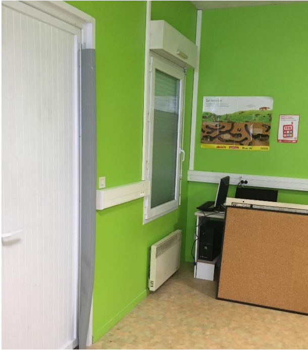
Photographies 3 et 4 : Salle polyvalente. Convecteur électrique ancien. Consigne de température par thermostat individuel non programmable. Entrée d'air dans coffre de volet roulant.
