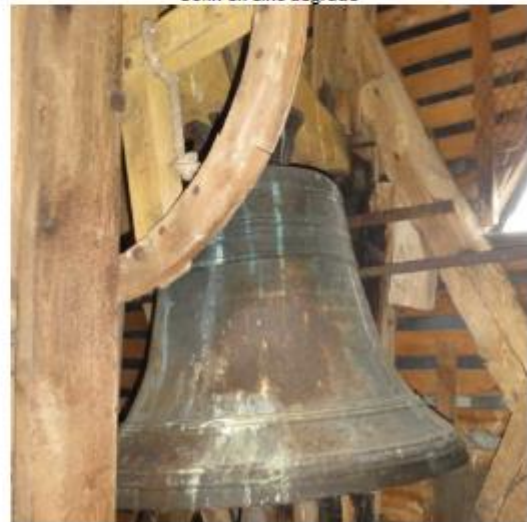
Oxydation sur la cloche
