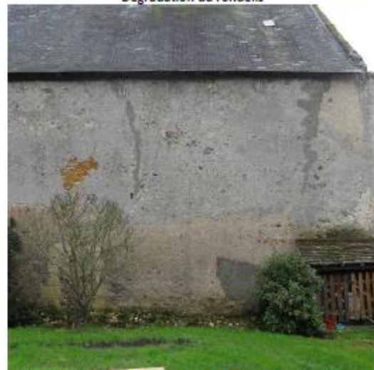
Enduit hydraulique et réparations au ciment en façade nord
