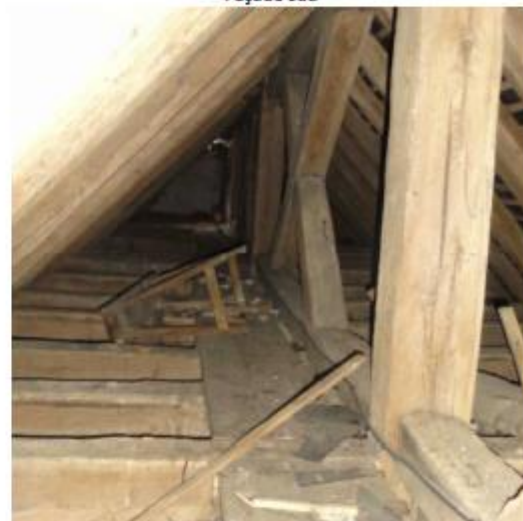
Faîtière de la charpente
