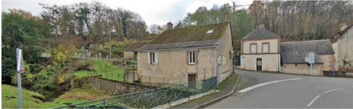
► Vue du site depuis le pont de la rue de Rougemont franchissant le ruisseau la Magdelon.
