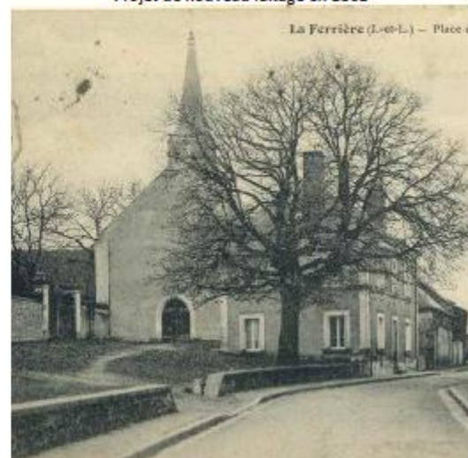
Vue de l'église à la fin du XIX e siècle, les contreforts sont en tuffeaux
