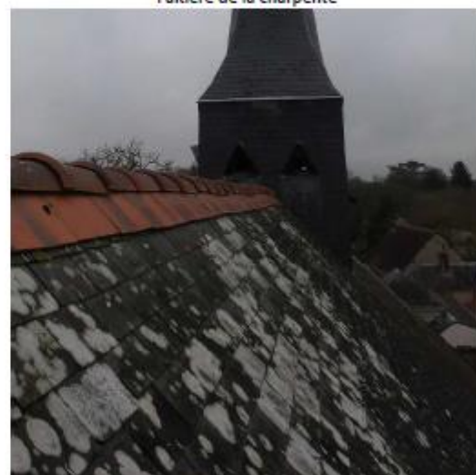
Toiture de la nef
