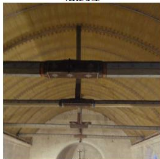
Voûte de la nef
