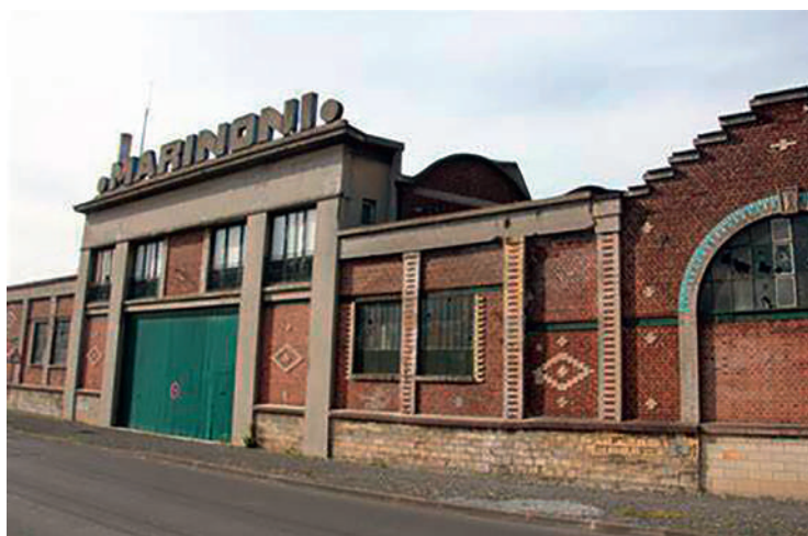
Façade de l'ancienne usine GOSS - Montataire
