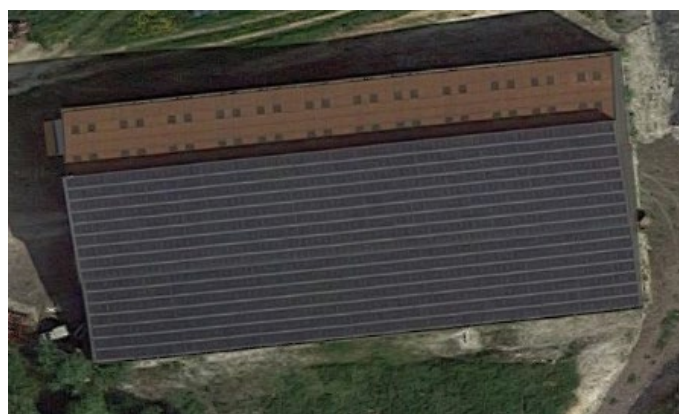
Figure 31 : Photo aérienne de la principale installation photovoltaïque d'Irles (Source : Googlemap)
