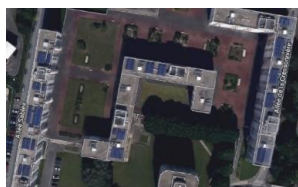
Résidence Tivoli à la Hotoie (solaire thermique)
