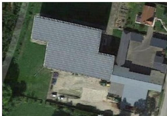
Figure 30 : Photo aérienne de la principale installation photovoltaïque de Béhencourt (Source : Googlemap)
