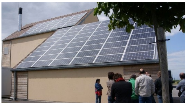
Figure 8 : Chaufferie bois de Montdidier
