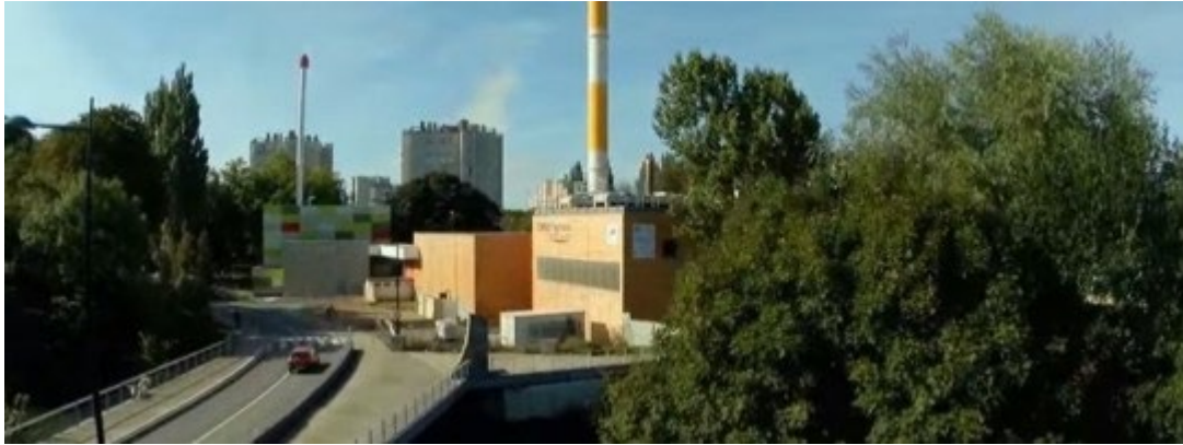
Figure 46 : Chaufferie du réseau de chaleur d'Etouvie (source : bioenergie-promotion.fr)
