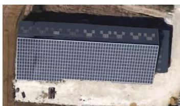
Toiture PV agricole à Poulainville
