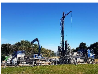
Forages géothermiques à Fouilloy
