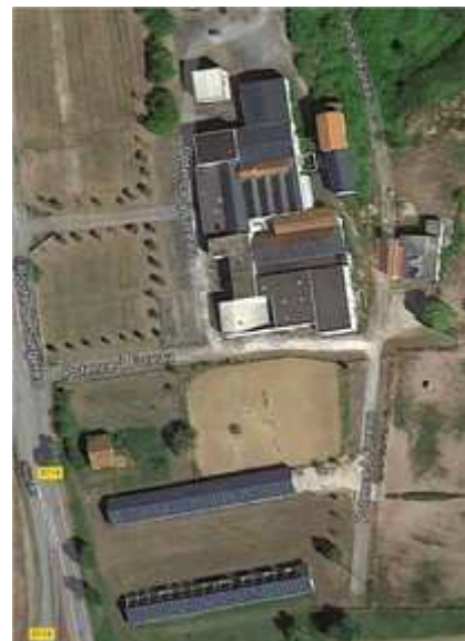
Hangars photovoltaïques (250 KW x 3) à Tonny-Boutonne et autres installations sur la commune
