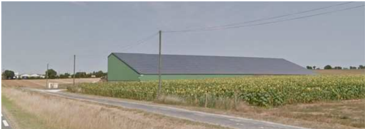
Hangar photovoltaïque (250 KW) à Pousay-Garnaud
