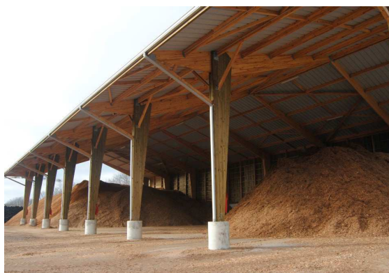
Plateforme bois-énergie de la 3CLG
