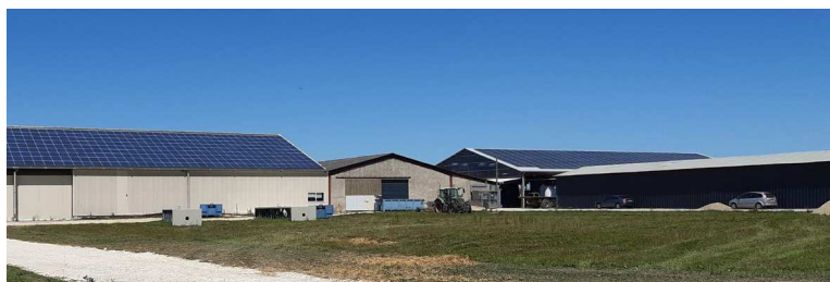
Panneaux photovoltaïque sur toiture, Monteton
