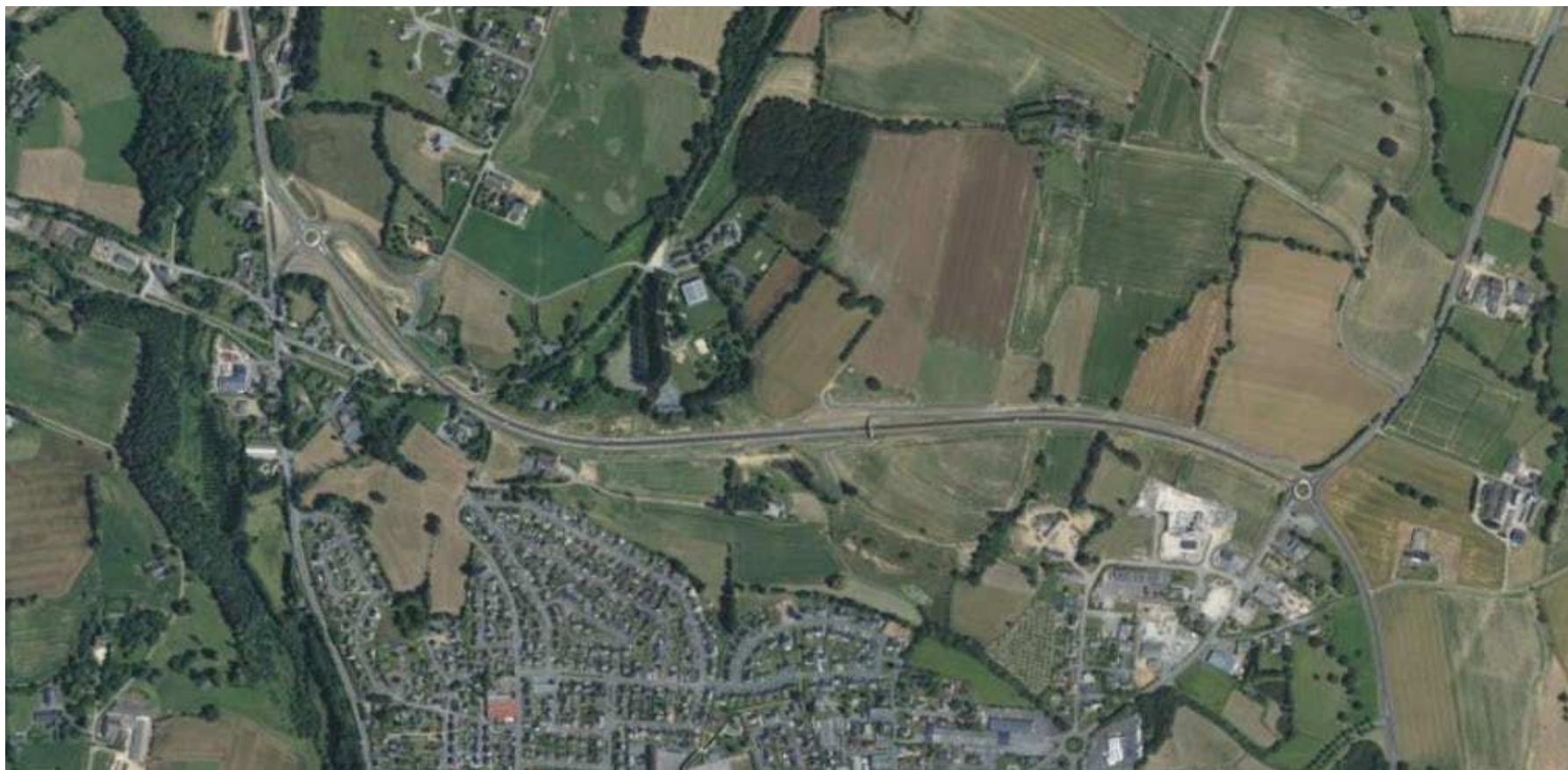
Vue aérienne des infrastructures routières aménagées
