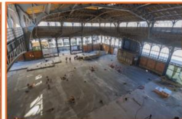
Construction des murs intérieurs © Ville de Limoges - Laurent Lagarde
