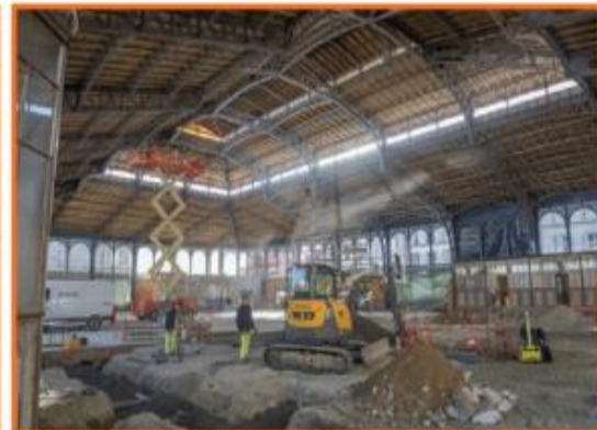
Passage des réseaux © Ville de Limoges - Laurent Lagarde
