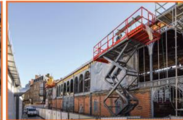
Remplacement du chéneau zinc © Ville de Limoges - Thierry Laporte
