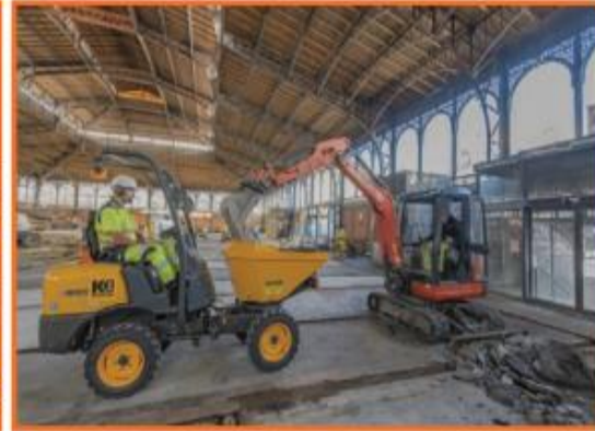
Démolition de la dalle béton intérieure © Ville de Limoges - Laurent Lagarde
