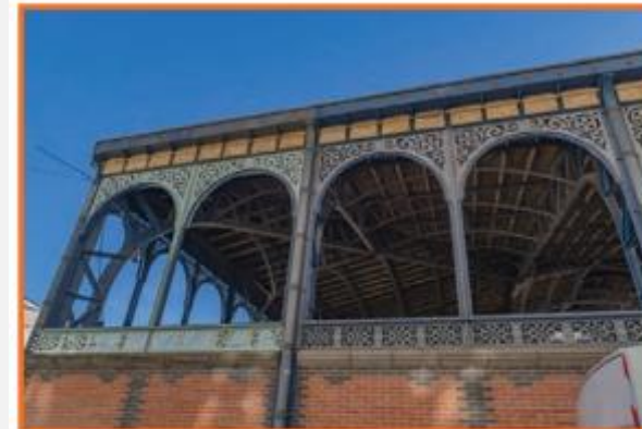
Mise en peinture de la façade © Ville de Limoges - Laurent Lagarde
