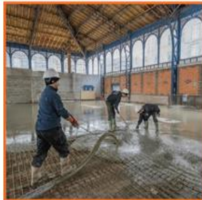
Coulage de la nouvelle dalle © Ville de Limoges - Laurent Lagarde
