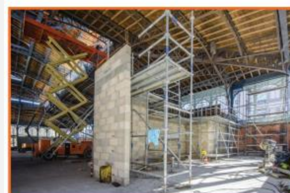
Construction des murs intérieurs © Ville de Limoges - Thierry Laporte
