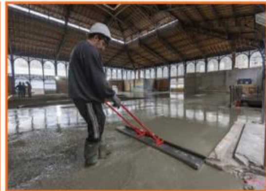
Coulage de la nouvelle dalle © Ville de Limoges - Laurent Lagarde
