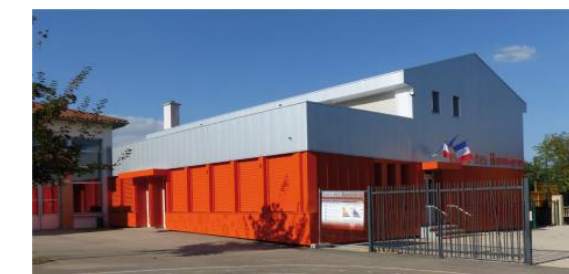
Rénovation énergétique école maternelle (AURA) - 200k€ FEDER
