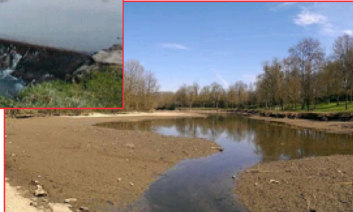
Après travaux en 2015
